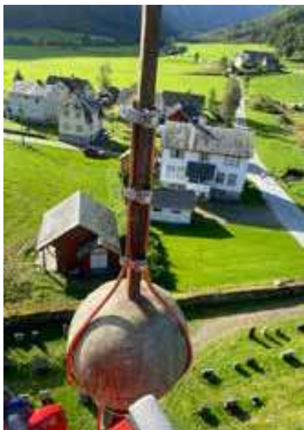
Nytt lynvernanlegg på taket på Fjærland kyrkje
