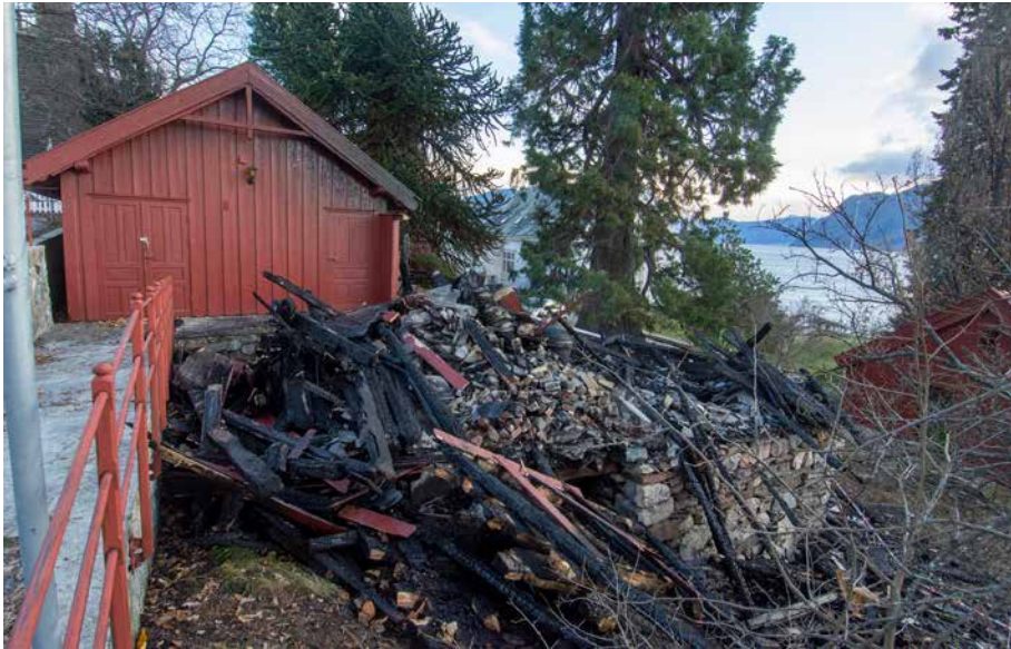
Utruleg nok greidde brannvernet å hindra at brannen spreidde seg frå eldhuset til bårhuset. Av det verna eldhuset er det berre att ein haug med brennt materiale.
