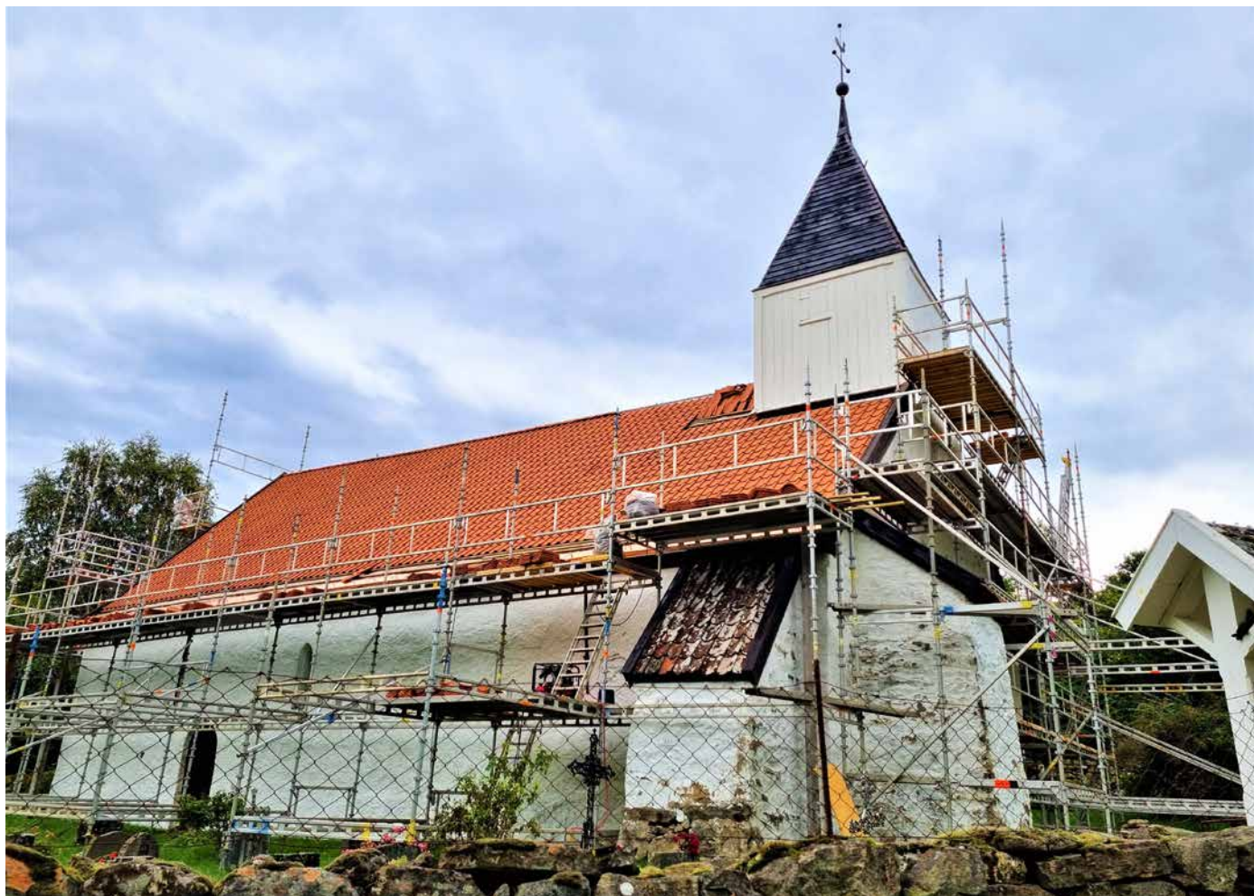
Stillas vart montert frittstående utan feste i kyrkjebygget. Det vart sett opp stillas rundt heile bygget. Foto: Vestlandshus Sogn
