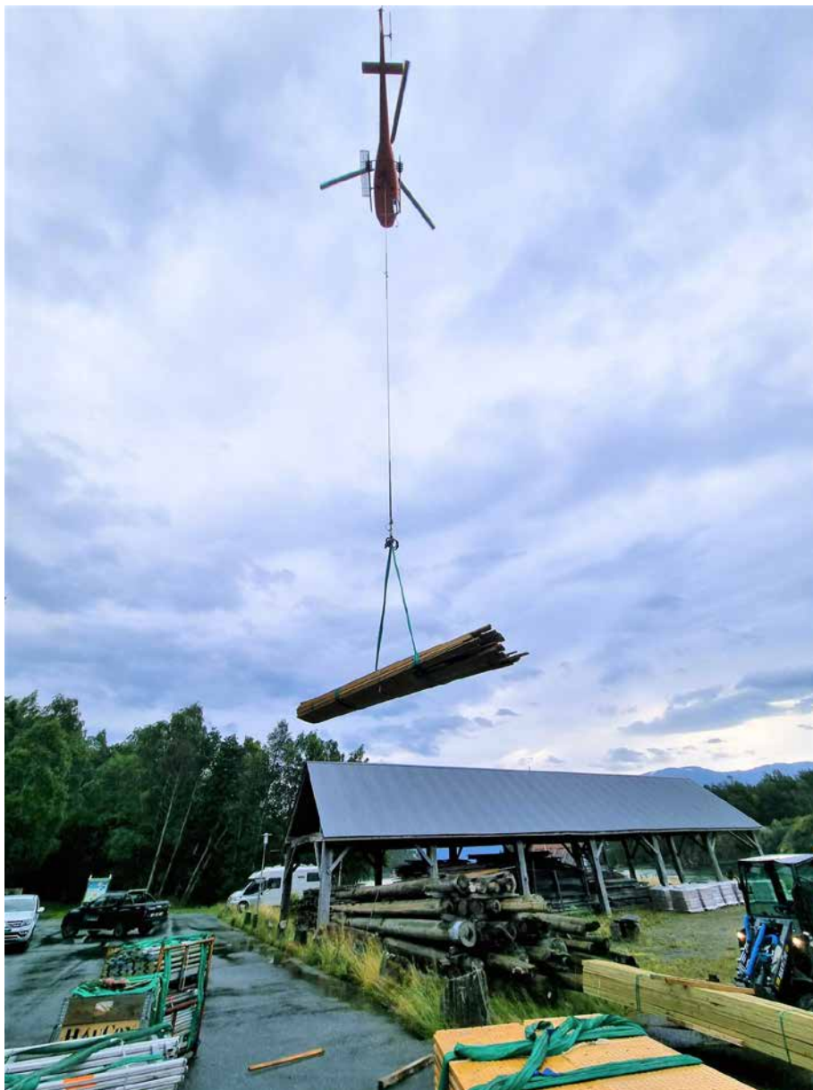
Stillas og materiale til utføring av arbeidet vart frakta over til Kvamsøy med om lag 60 helikopterløft samt at noko vart ført over med båt. Foto: Vestlandshus Sogn
