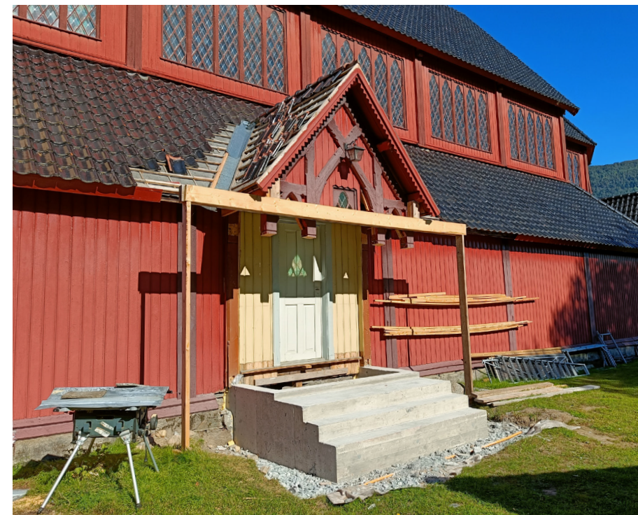
Trappa under sideinngangen på Stedje har blitt fjerna, og erstatta av ny trapp.
