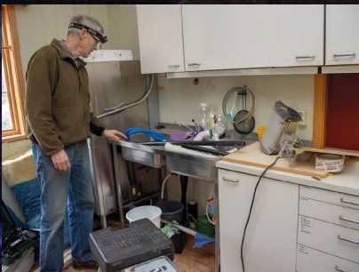
Kjøkenet snart ferdig, side 6-7
