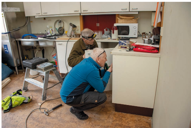
Henry Neverdal og Kolbjørn Nord slit med å demontera kjøpenskåpa. Her gjeld det å vera varsame for skåpa skal monerast på plass att når nytt golvbelegg er lagt, og veggene er pussa ned og måla.
