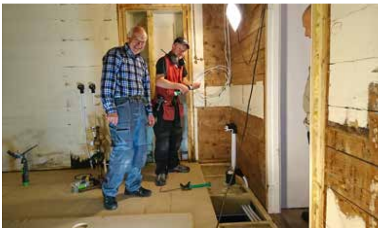
Vidar Heier og Erland Fagermoen monterer dei siste golvplatene på gamlekjøkenet som mellom anna skal gi plass til toalett og bøttekott.
